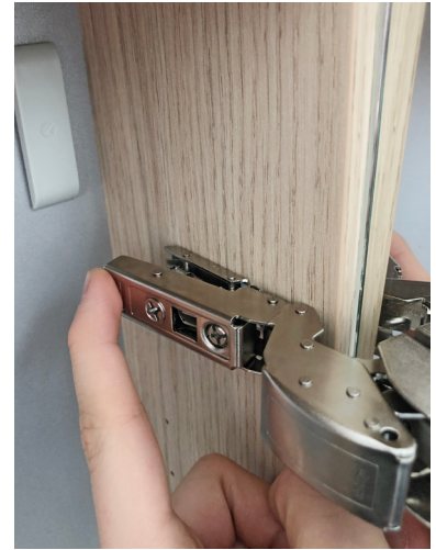
Abb. 1c | Montage Spiegeltür
