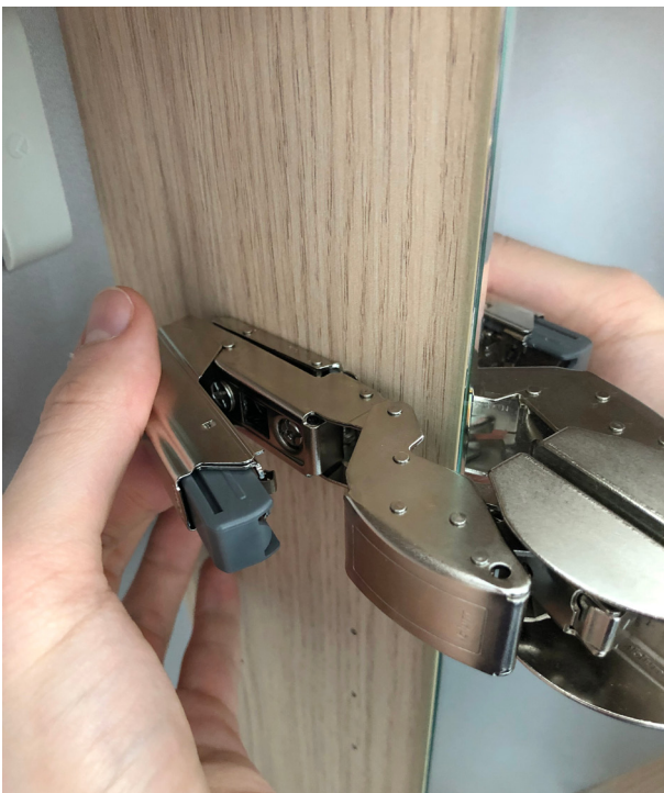
Abb. 4 | Montage von Glastürdämpfung und Abdeckkappe
