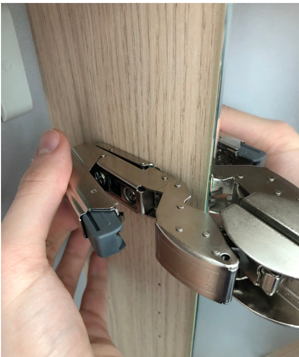
Abb. 4 | Montage von Glastürdämpfung und Abdeckkappe
