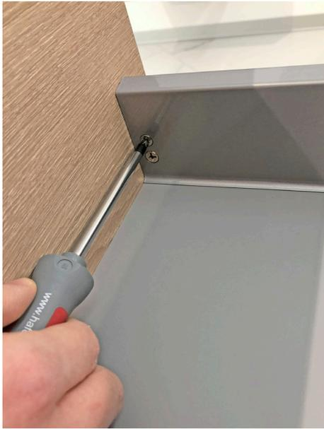
**3a.** obere Schraube etwas lösen, damit die Front verstellt werden kann.
