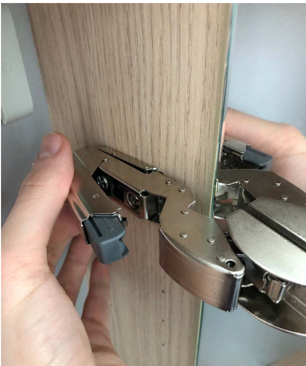
Abb. 4 | Montage von Glastürdämpfung und Abdeckkappe
