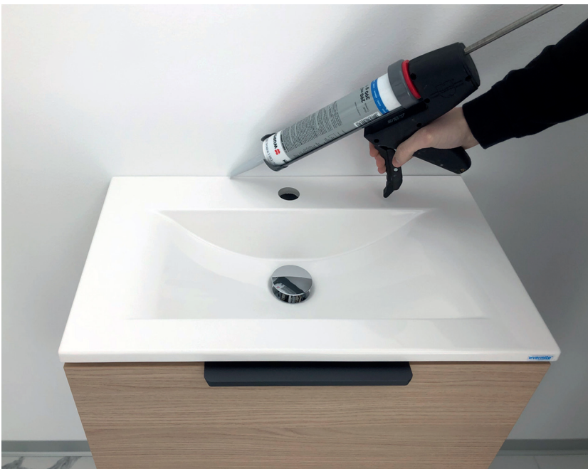
Abb. 4 | Waschtisch-Montage / Abdichten zur Wand mit Silikon
