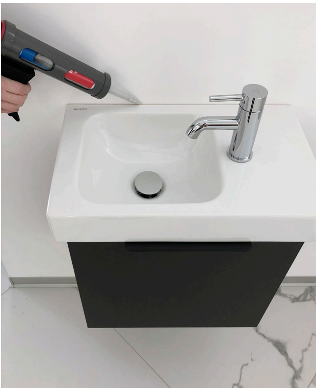
Abb. 6 | Waschtisch-Montage / Abdichten zur Wand mit Silikon
