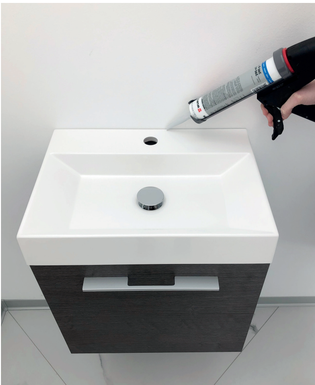
Abb. 6 | Waschtisch-Montage / Abdichten zur Wand mit Silikon
