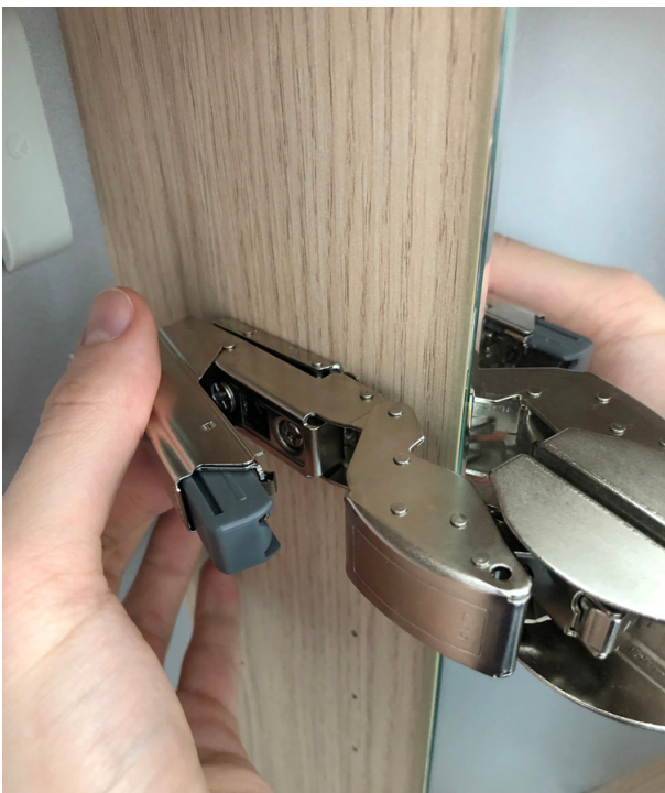
Abb. 4 | Montage von Glastürdämpfung und Abdeckkappe
